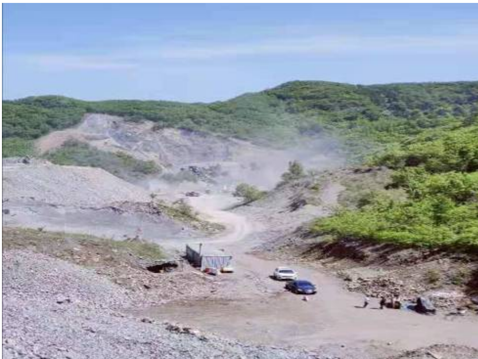
图 3-4 房屋及道路照片
