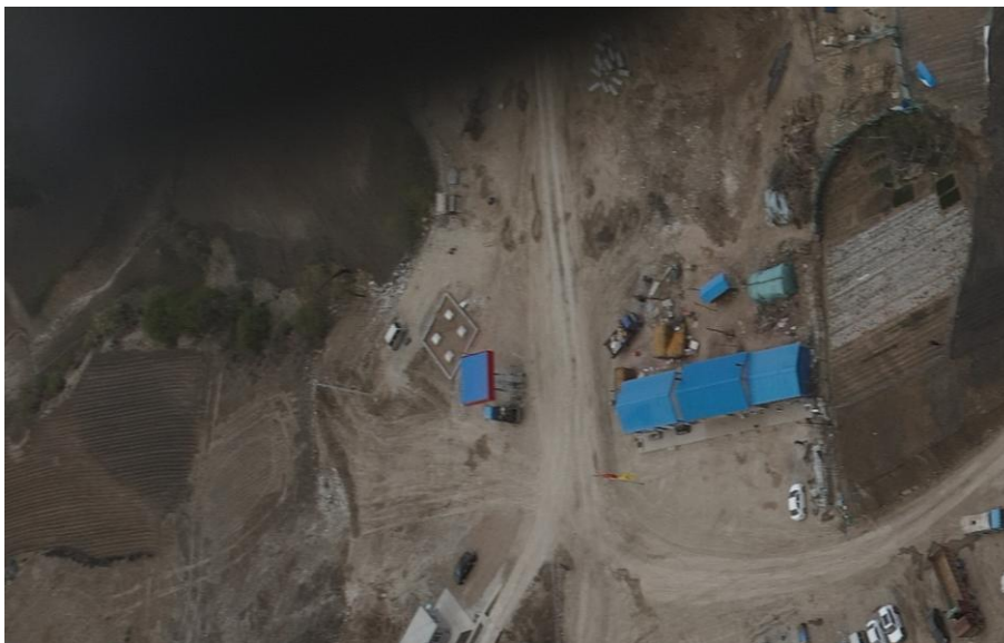
图 3-7 矿区办公生活区
